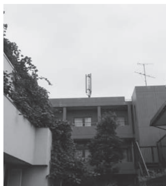
▲3階建てマンション屋上に設置された携帯基地局
